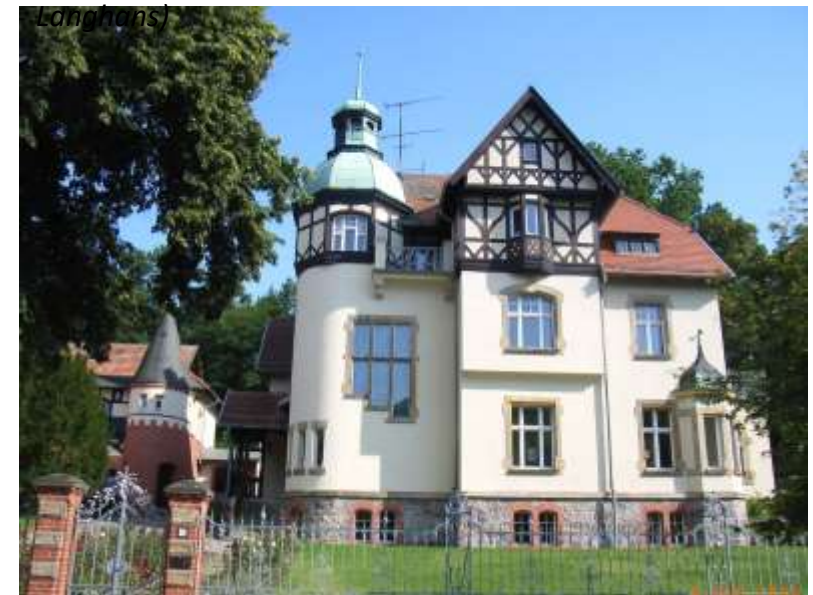
Abb. 2: Villa Katharina (um 1900 errichtet)
