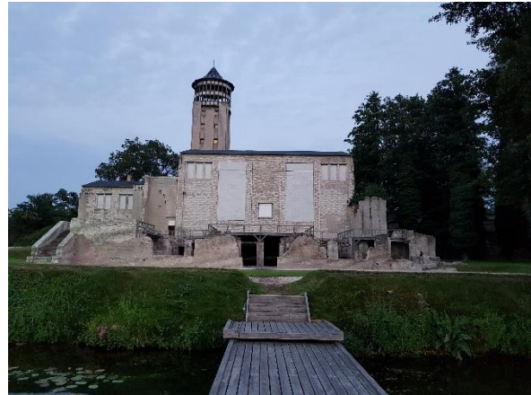
Abbildung 6: Turbinenhalle am Stienitzsee
